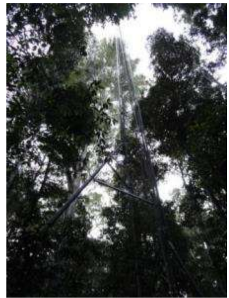
Einer der 80 m hohen Messtürme
